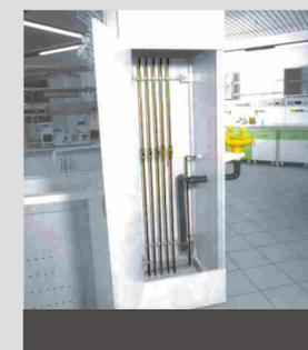
Nel caso gli impianti siano predisposti a pavimento è prevista l'installazione di speciali armadi tecnici per supportare il "satellite".
